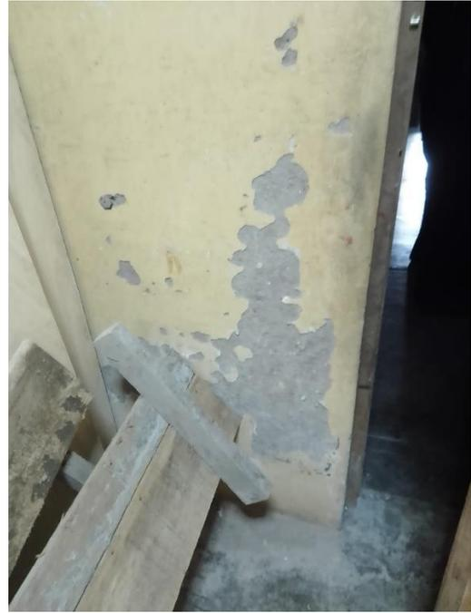
Paredes húmedas y columnas que se caen muestran que la construcción está débil desde sus cimientos y es necesario romper y cambiar columnas
